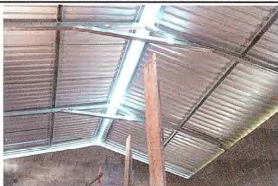
Foto 3: Cambiando el entechado de lamina dañada por lamina troquelada 26mm
