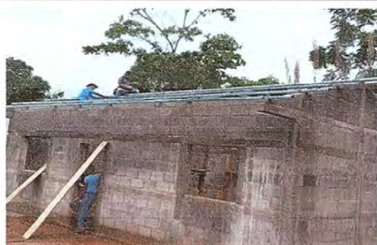
Foto 4: Terminado la pared y colocacion de estructura metálica del aula
