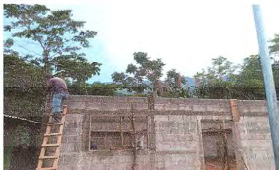
Foto 1: Haciendo llegar la altura de la pared que estaba inconclusa
