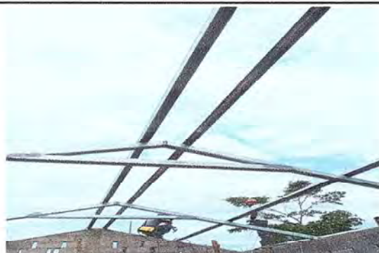
Foto 2: Reemplazando costanera de madera por estructura metálica
