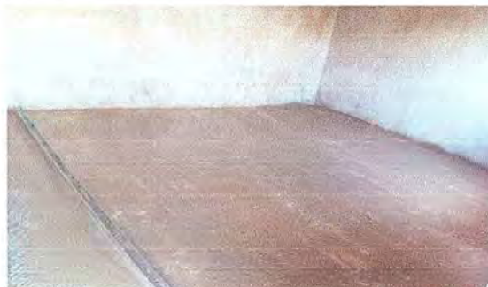
Foto 6: Colocando piso en uno de los modulos
