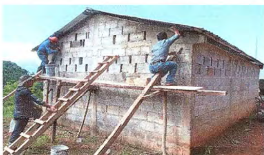
Foto 5: Iniciando repello de pared
